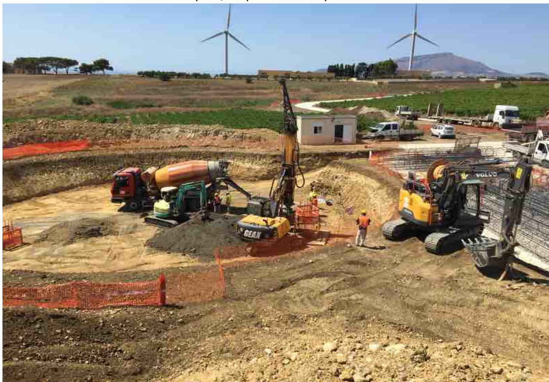
Cantiere di località Fumosa comune di Trapani, ampliamento impianto eolico ASJA Ambiente Italia S.P.A.
