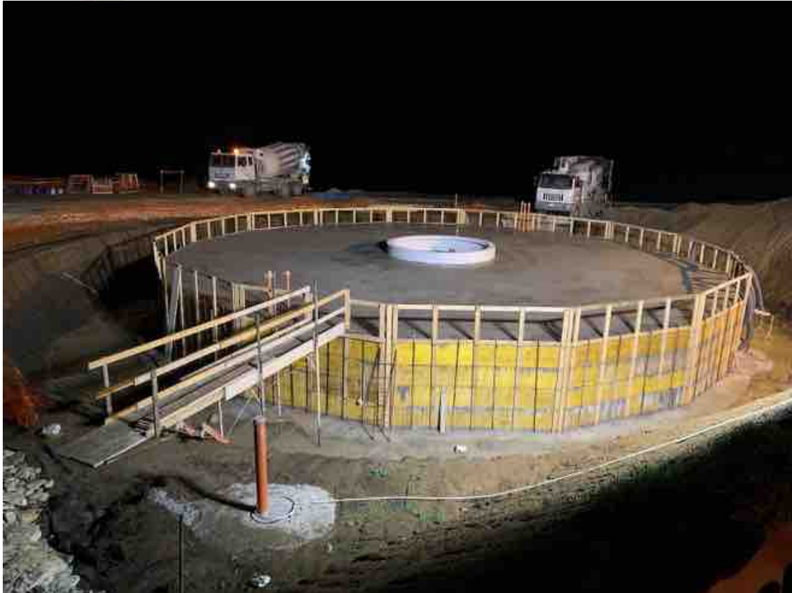
Cantiere di località Mola comune di Buseto, ampliamento impianto eolico ASJA Ambiente Italia S.P.A.
