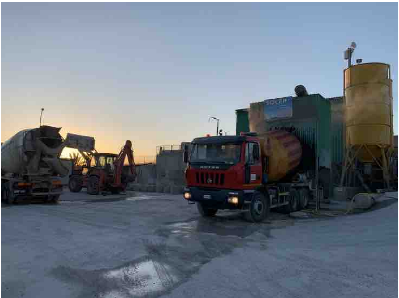
Nostro stabilimento per la produzione di calcestruzzo
