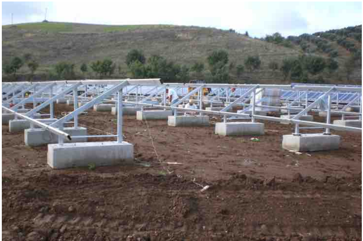
Cantiere di Altomonte impianto Fotovoltaico ENEL GREEN POWER
