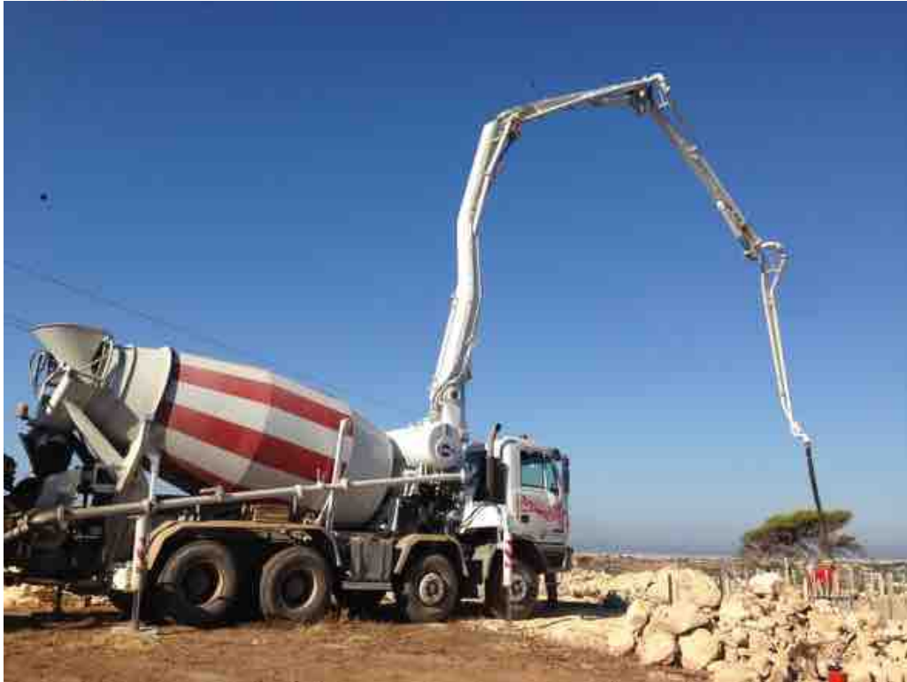
Cantiere C/da Gurgo Marsala impianto minieolico da 60KW ENDURANCE
