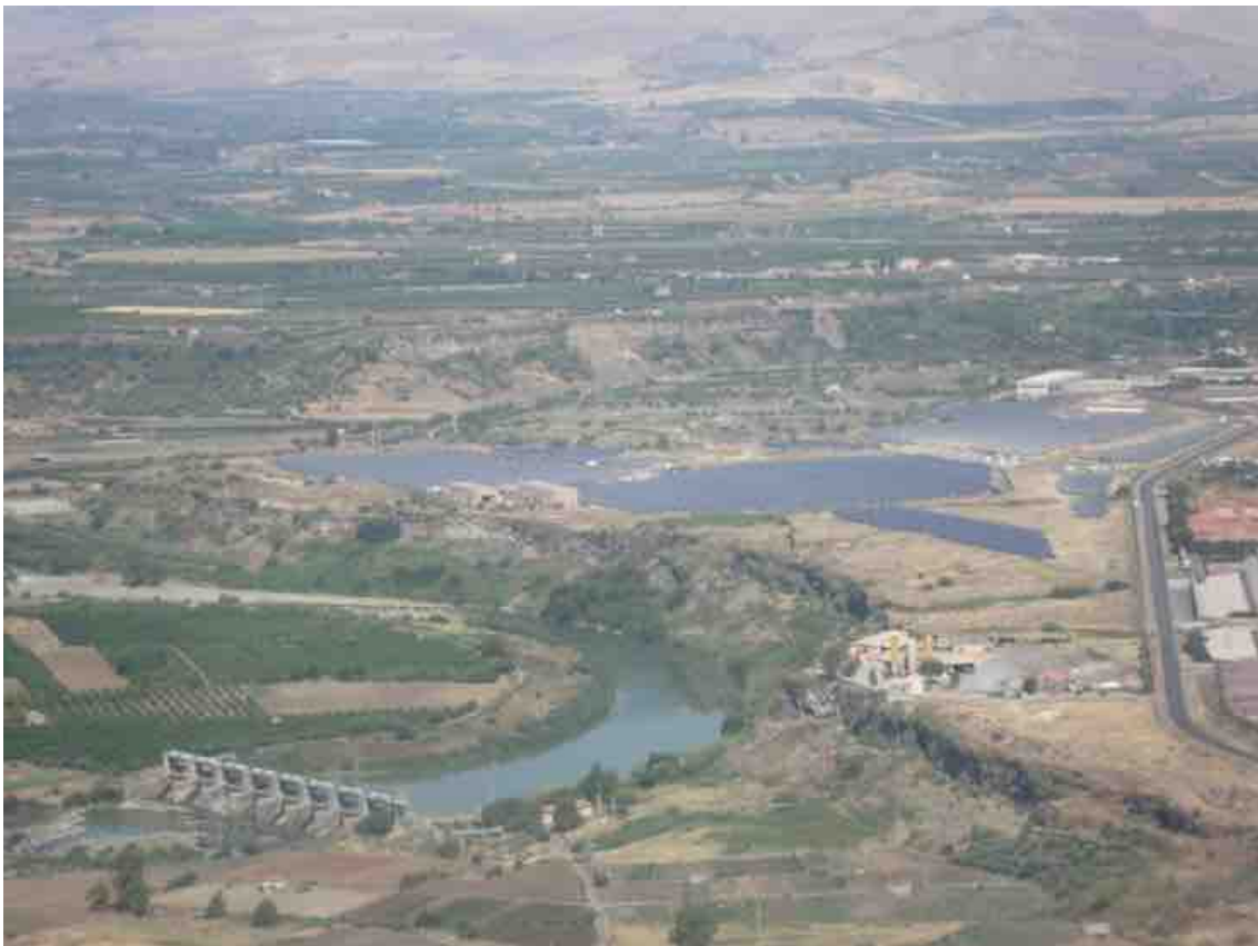
Cantiere di Adrano impianto Fotovoltaico ENEL GREEN POWER
