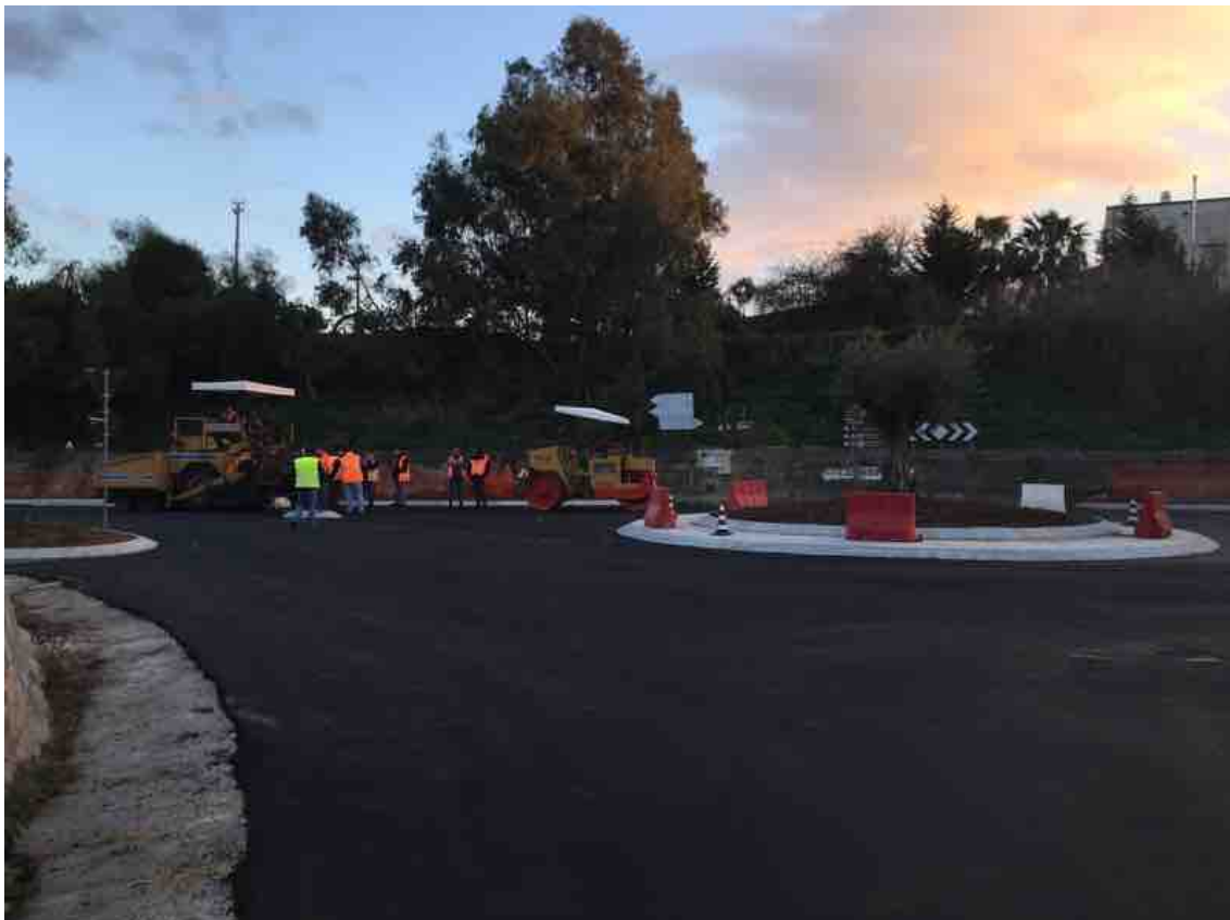
Cantiere Alcamo, realizzazione rotatoria nell'intersezione tra la SS113 e la SP55
