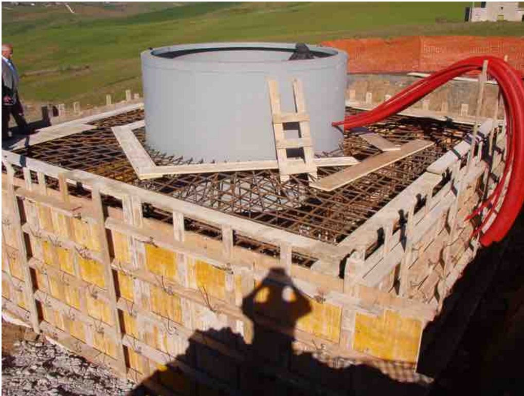
Cantiere di Salemi impianto Eolico MWp 5,98 ASJA AMBIENTE ITALIA S.P.A.
