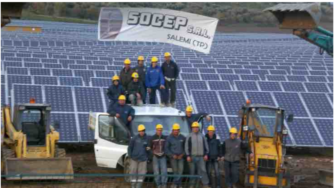
Cantiere di Altomonte impianto Fotovoltaico ENEL GREEN POWER
